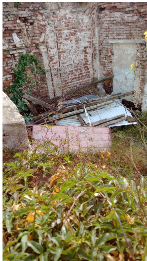
Foto 4 — Escombros y materiales de demolición acumulados en el fondo del predio.
