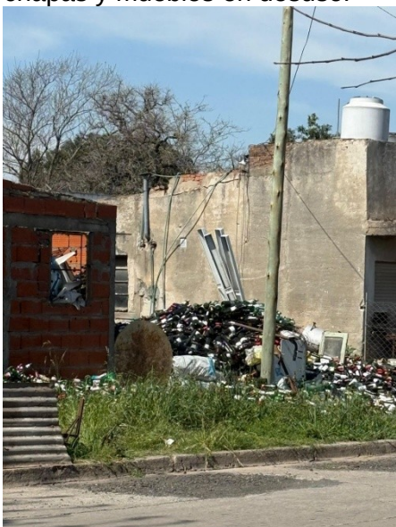
Foto 3: Detalle del sector: residuos sobre la vereda junto al poste de tendido aéreo.
