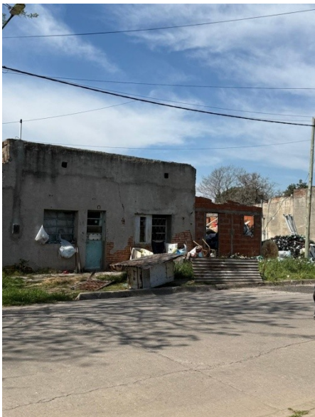
Foto 1: Vista general del frente: vivienda, construcción precaria y vereda con residuos, chatarra, bolsas y objetos varios sobre el chapas y muebles en desuso.
